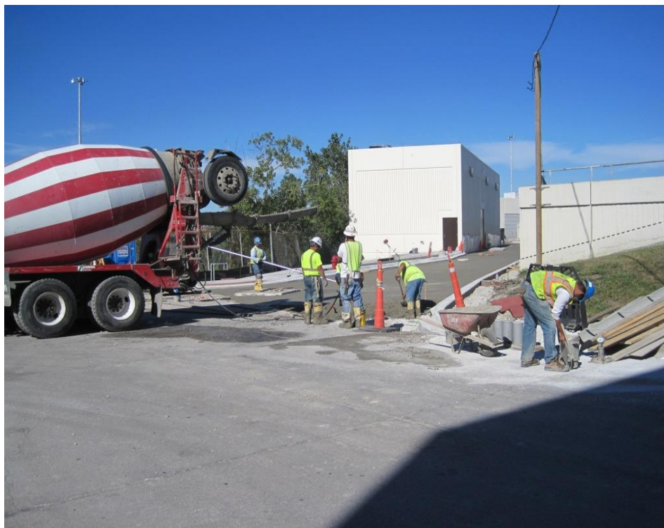
North Road Concrete Pour
